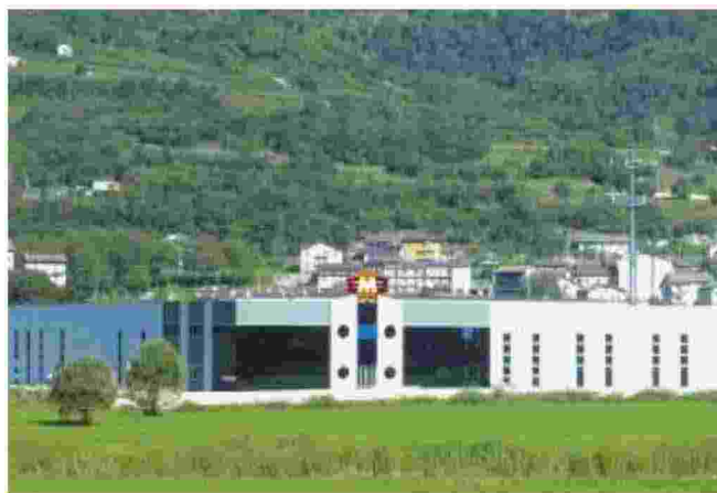
Lo stabilimento Orange1 ad Arsìe (Belluno)
